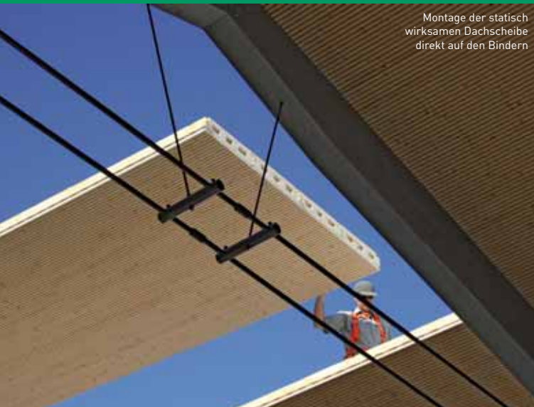
LIGNO Block Q3 Akustik (Leistenprofil 8 mm, Fichte) (Sporthalle Kadelburg)
